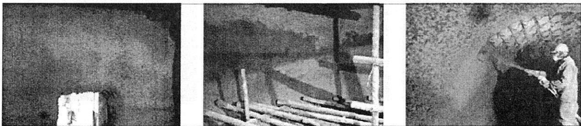
Fig. 7 Rotary Kiln Pre-Heater 및 Secondary Air Duct 부위 시공 사진
