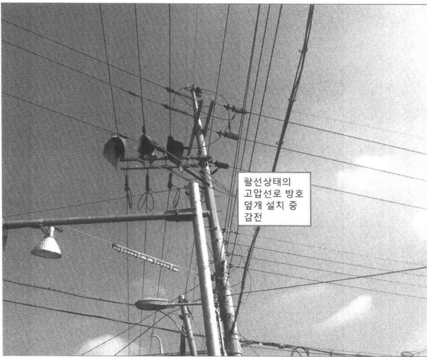
재해 당시 사고 발생 전주의 절연용 방호구 설치 상태
