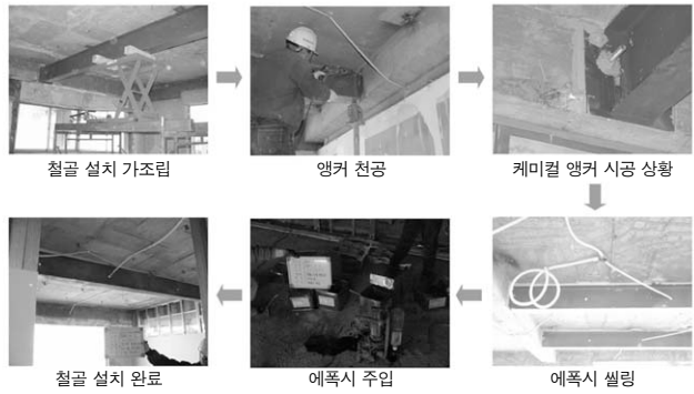
그림 4 철골 빔의 보강방법 및 시공 순서
