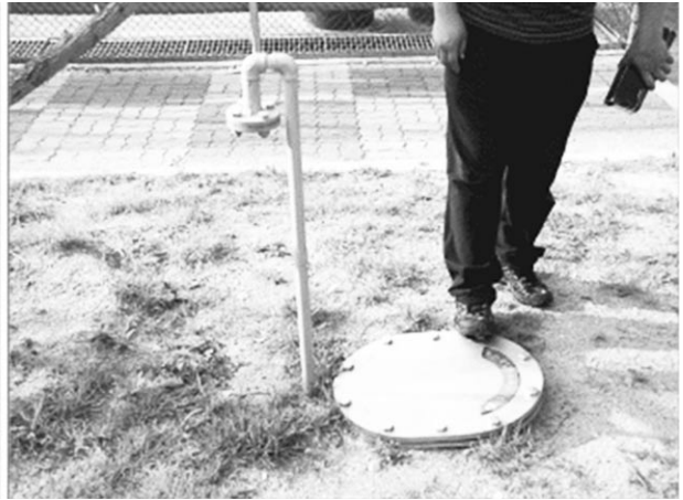
[그림 5] 개방형 지열공 천공시 부실관리(좌) 및 천공 후 적절한 마감 사례(이진용 등, 2008)
