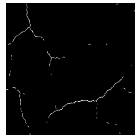
그림 9. 추출된 균열 영상 Fig. 9. Extracted crack image.
