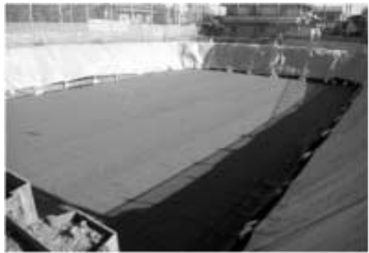
④ 보호시트 시공(2겹)
