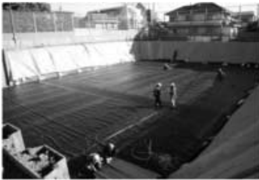
③ 차수시트 시공
