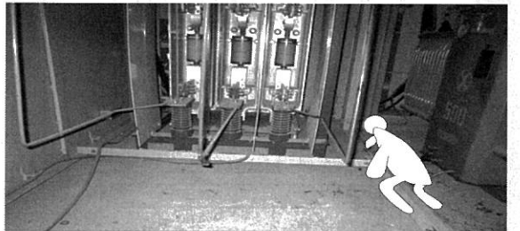
【사진 6】 사고 당시의 피해자 쫓겨려 었던 자세(오른손으로 바닥의 철재 프레임을 잡고 있는 상태에서 좌측 등이 전선에 접촉한 것으로 추정)
