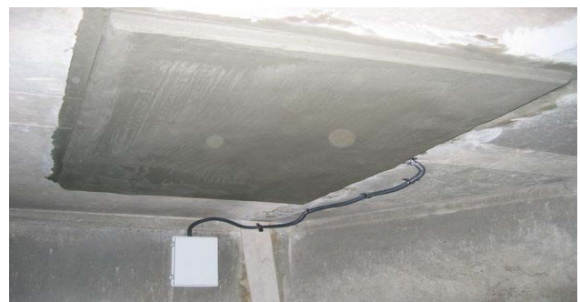
(d) Completion of construction
