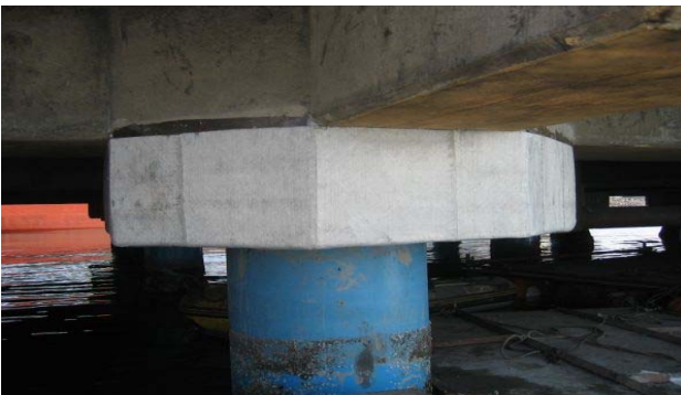
(d) Completion of construction
