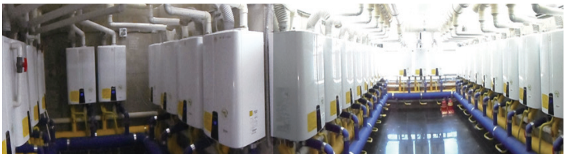
[그림 1] 서울 명동 스카이하크 호텔 센트럴점에 설치된 Cascade System
