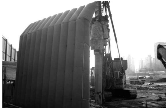
그림 4 향타기 방음커버 및 가설방음벽
