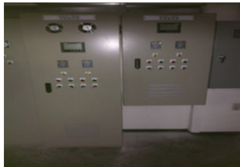
[그림 7] DDC 및 인버터 패널 설치
