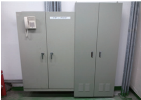
[그림 7] DDC 및 인버터 패널 설치
