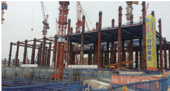
사진 1. 합성부재를 적용한 UP-UP 공법 시공사진
