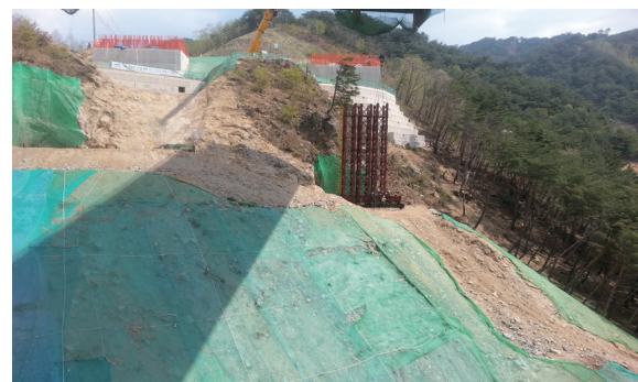
사진 6. 가설벤트 설치 현황
