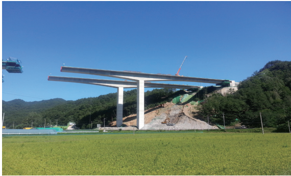
사진 11. 종점부 시공완료 후 전경
