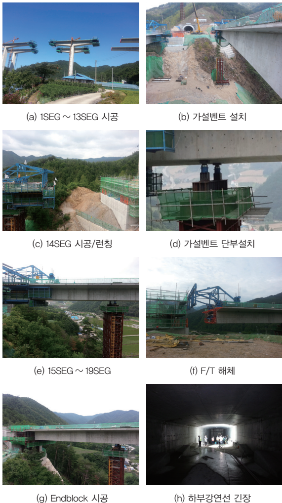
사진 5. Unbalance FCM 시공순서
