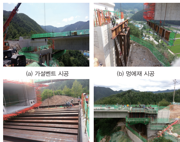
(a) 가설벤트 시공 (b) 명에재 시공 (c) 장선재 시공 (d) 구조물 시공
