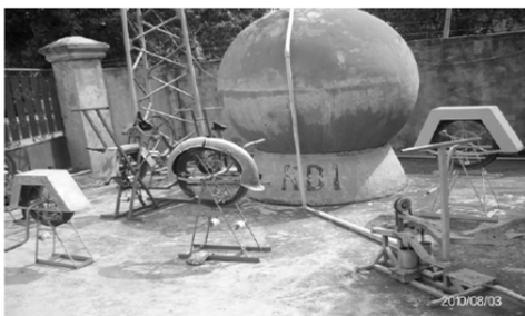
물탱크와 펌프(RDI 자체 개발)
