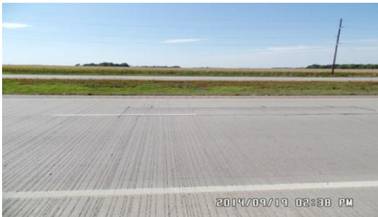
(a) 종방향 균열 보수
