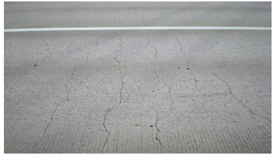
그림 11. 중부고속도로 연속철근콘크리트 포장
