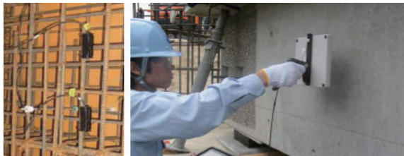
그림 4. RFID 태그의 설치상황(좌) 및 계측상황(우)
