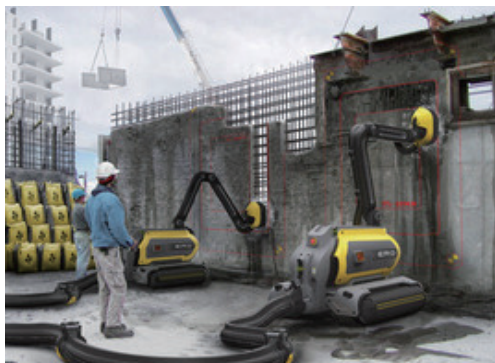
사진 1. 콘크리트 해체 리사이클 로봇 시스템
