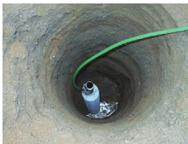
사진 1. 전도성 접지봉의 대지내 시공 18)
