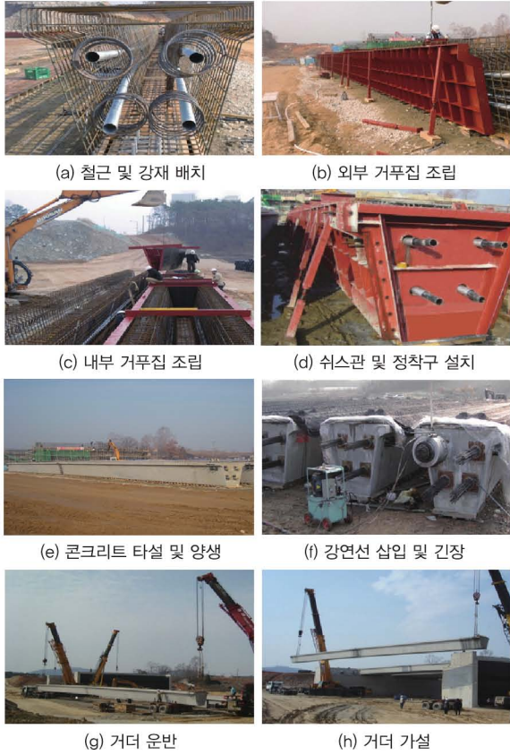
사진 1. V-Girder 시공순서
