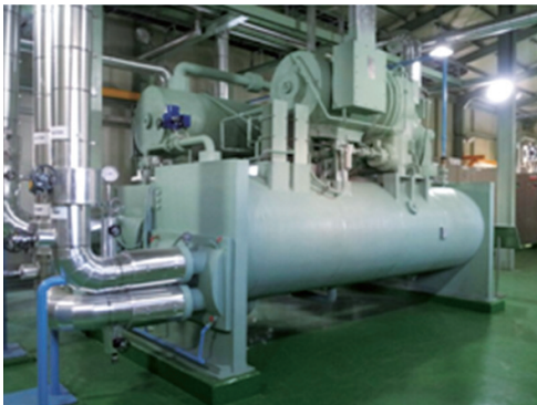
[그림 5] 연료전지 저온냉각수 히트펌프 설치 사진
