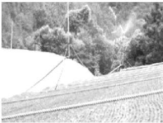
축사 지붕 위 물 분사
