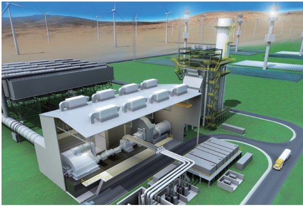
그림 7. 풍력-태양-천연가스 발전소 개념도(좌) 및 출력 변동성 추종 가스터빈(우) [11]
