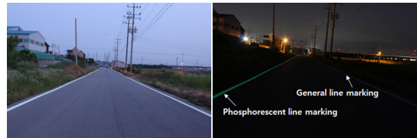
Fig. 6 Test Construction Site
