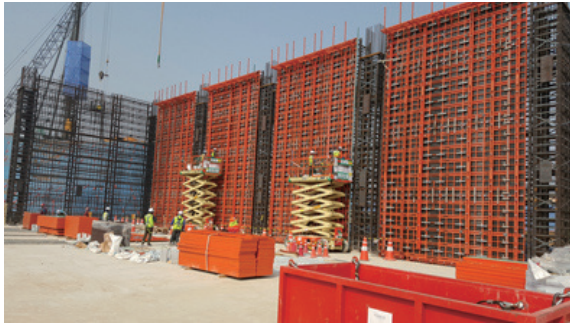
사진 3. SSP WALL 거푸집/조립식 발판
