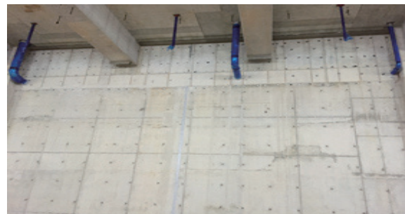
사진 7. RC 공법 타설 후 벽체 형상
