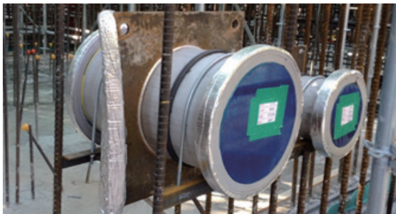
사진 4. 기존 슬리브 설치 형상
