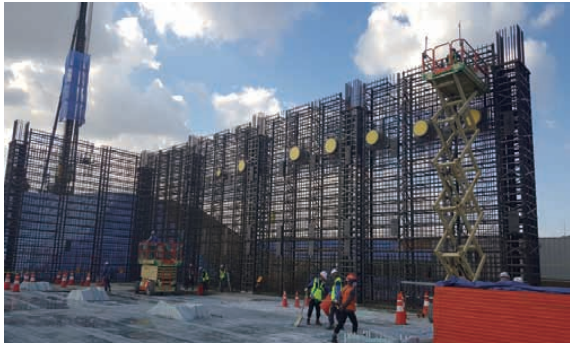
(a) SSP WALL 설치
