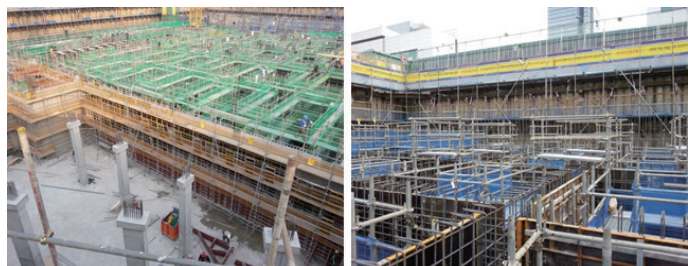
사진 1. 기존 RC공법 현장 전경
