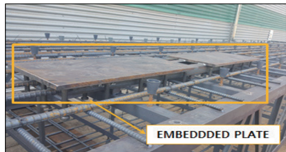
사진 6. 임베디드 플레이트 공장 설치
