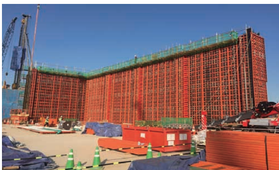
(b) 거푸집 설치된 SSP WALL
