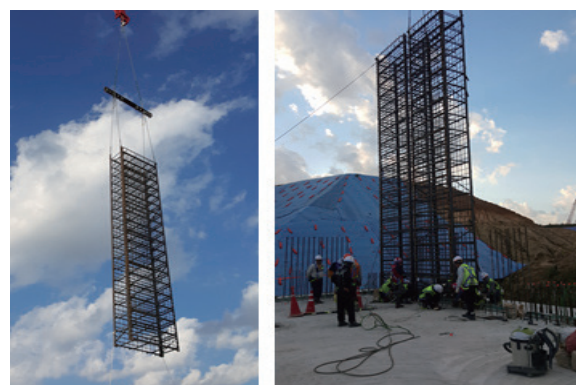
사진 2. SSP WALL 양중 및 설치
