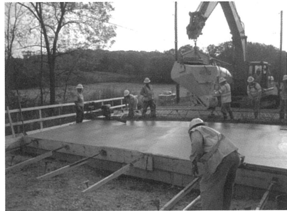
그림 5. 내부양생이 적용된 콘크리트의 시공 현장(Bloomington, USA) 10)
