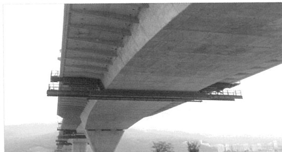
사진 1. 낙동대교 Key Seg 시공 전경 (위 : F/T 이용, 아래 : Key Seg Form 이용)
