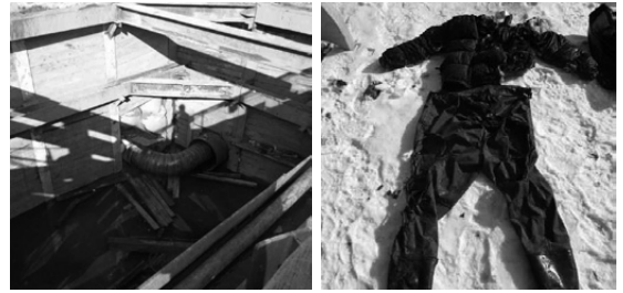
강관내부 용접 중 작업복에 착화로 1명 사망 ('12.12.25, 대전 동구)
