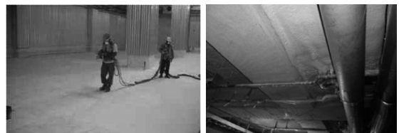
냉동창고 벽면·바닥 스프레이 시공
