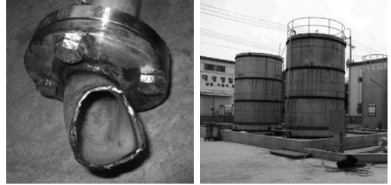
구 톨루엔 저장탱크 이전 설치 용접 중 폭발로 2명 사망 ('11.7.10, 경기 시흥)
