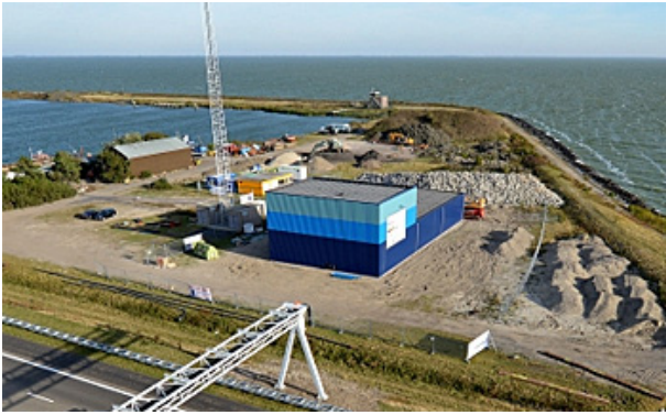
Fig. 1. REDStack plant on the closure dam Afsluitdijk.
