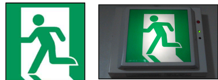
그림 4. 비상구 표시 Fig. 4. Emergency Exit
