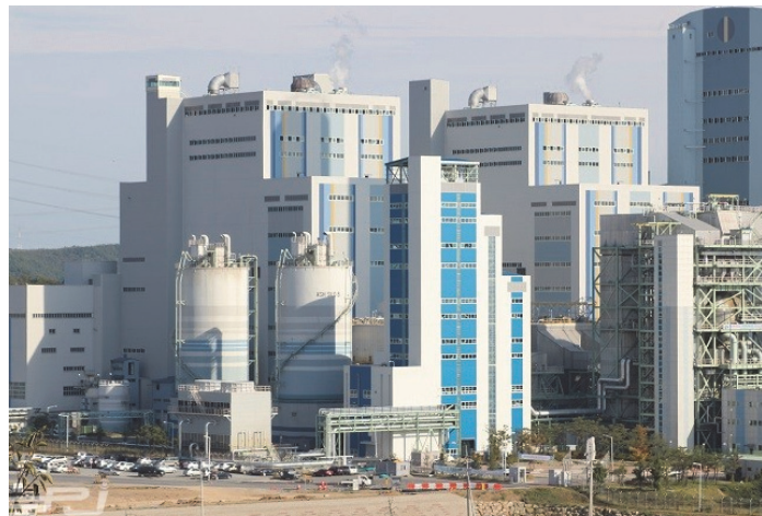
Fig. 2. 한국남부발전(주) 하동화력본부 10 MW 건식 포집플랜트 전경 [8].
