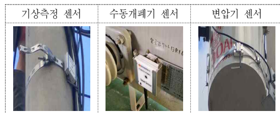
<그림 6> 배전계통 감시용 IoT 센서
