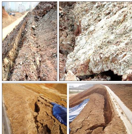
그림 6. 유천층군의 응회암이 분포하는 지역의 도로 사면에서 발생하는 배부름 현상 및 사면붕괴
