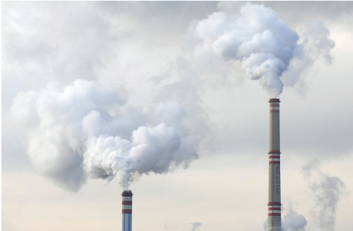
그림 1. 벤트 스택 굴뚝 폐열 시스템 Fig. 1 Chimney waste heat system in vent stack
