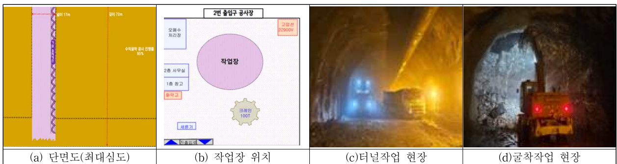
그림 2. 지하역사 작업현장 Figure 2. Subway Station Worksite
