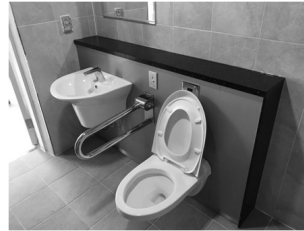
그림 9. 병실 부속 화장실의 위생도기 설치 사례
